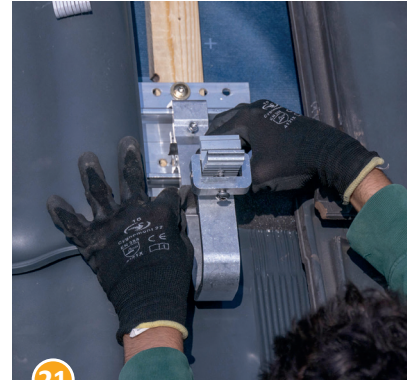
21 Einschnitt am Schaumstoffkeil um den Dachhaken...
