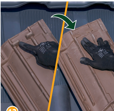
13 Die Verriegelungsnasen auf der Rückseite der einzuhängenden Tonziegel entfernen.
