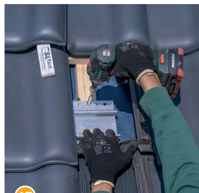
17 Fuß des Dachhakens auf dem Dachsparren ausrichten und mit mind. 2 Holzschrauben (mind. 1 Stück pro horizontale Lochreihe, 10 Nm)...
