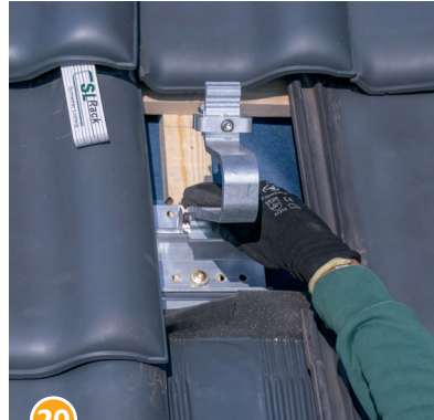
20 Dachhaken in Fuß einhängen.
