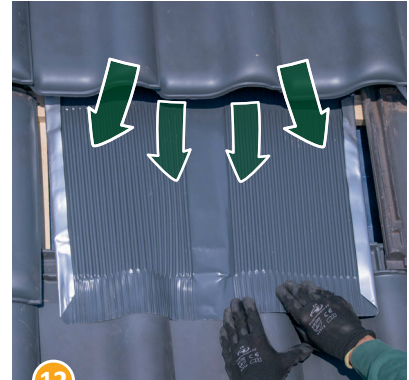
12 Dabei wieder darauf achten, dass sich im mittleren und oberen Bereich keine Wassersäcke bilden.
