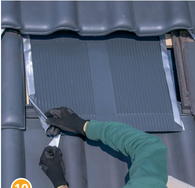
10 Schutzfolie des Klebestreifens auf der Unterseite der Beta-Platte abziehen.
