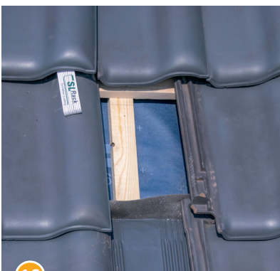
16 Dacheindeckung über Beta-Platte aufdecken.
