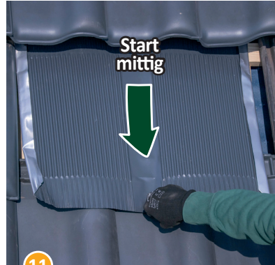
11 Beta-Platte beginnend von der Mitte nach außen fest und formschlüssig andrücken.
